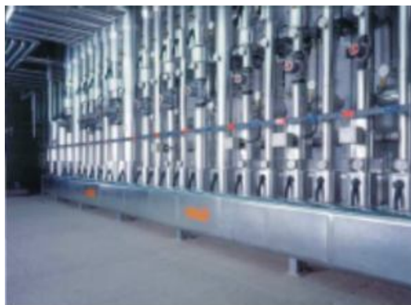
▲ Układ z rozdzielaczem w całości zaizolowanym
