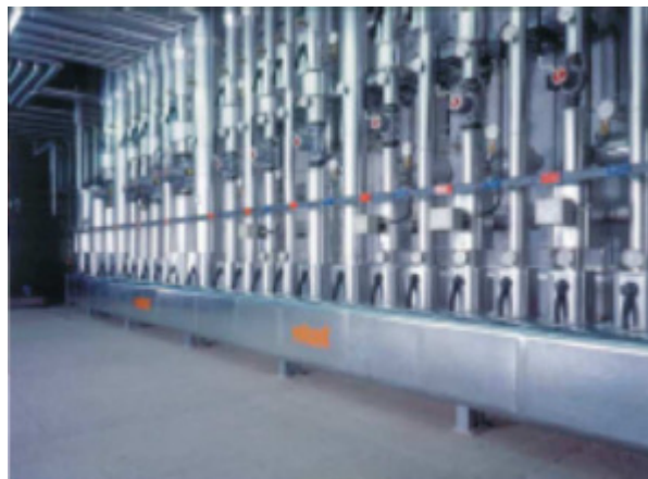
▲ Układ z rozdzielaczem w całości zaizolowanym
