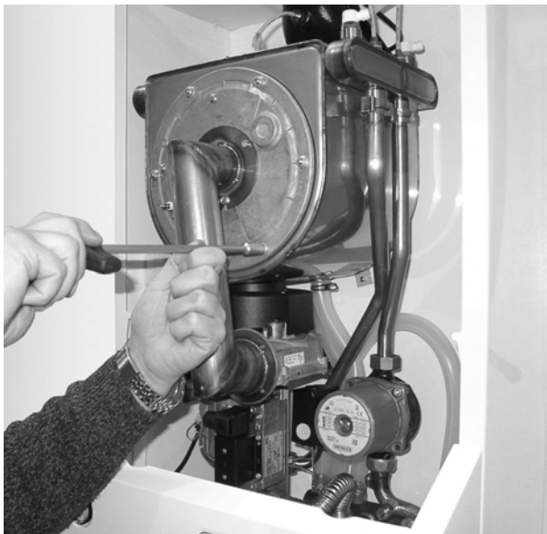
Rys. 34 : Odkręcić śruby mocujące płytę palnika.
