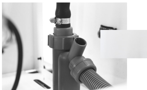
Rys. 12: Syfon i szlauch do odprowadzenia kondensatu.
