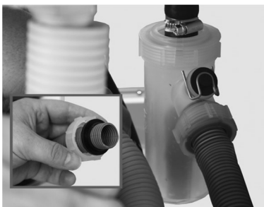
Rys. 8: Syfon i szlauch kondensatu.
