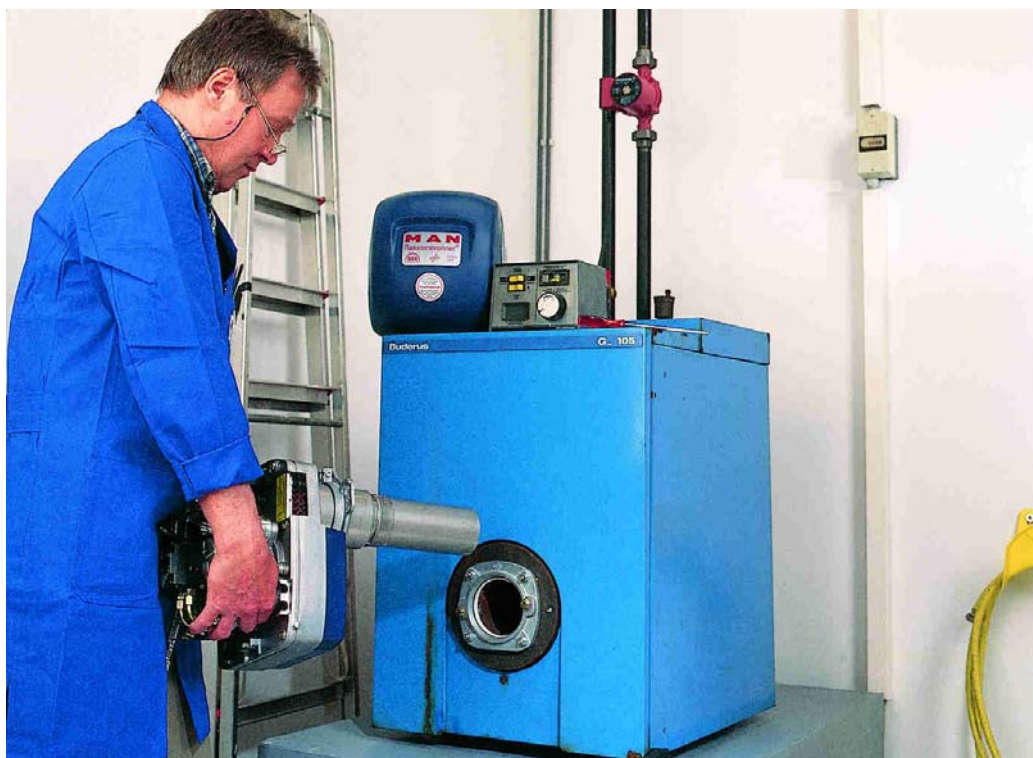
Zdjęcie I: Montaż palnika - kotła I
