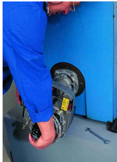
Zdjęcie III: Montaż palnika - kotła III
