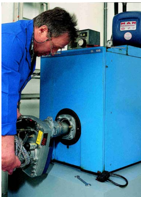
Zdjęcie II: Montaż palnika - kotła II
