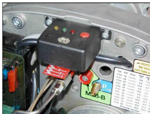
Rys.8. Pole diodowe oraz króciec Maß- B
