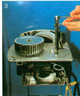
3. Palnik w zawieszeniu do prac serwisowych dla wymiany dyszy
