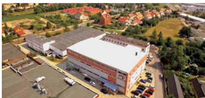
Domino, magazyn i hala produkcyjna, Dzierżoniów (2016)
