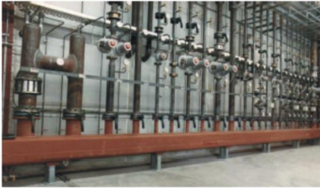
▲ Układ z rozdzielnikiem w trakcie montażu
