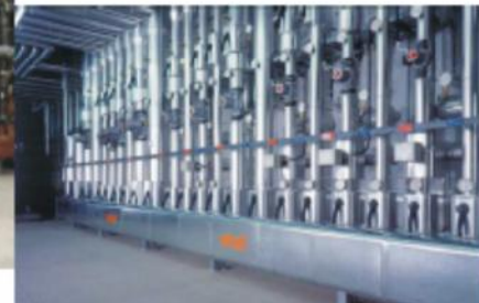
▲ Rozdzielnik w wykonaniu z termicznym rozdzieleniem komór
