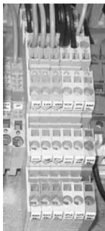
Zdjęcie 14 Zaciski kostki sprężynowej
